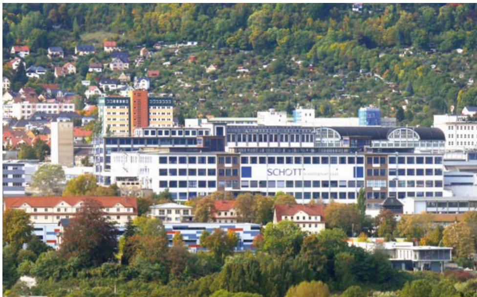
Zu reaktivierende Gebäudesubstanz im Areal Tatzendpromenade
