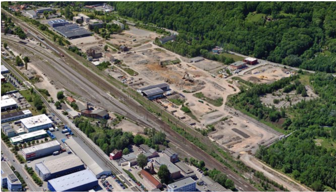
Erschließung des Gewerbegebietes »Jena21«
